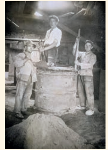
Produktion von Brunnenringen in der alten Werkstatt.
