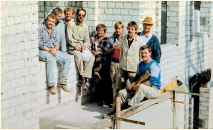
Mitarbeiter beim Bau vom St. Anna Stift in Hagen 1988.
