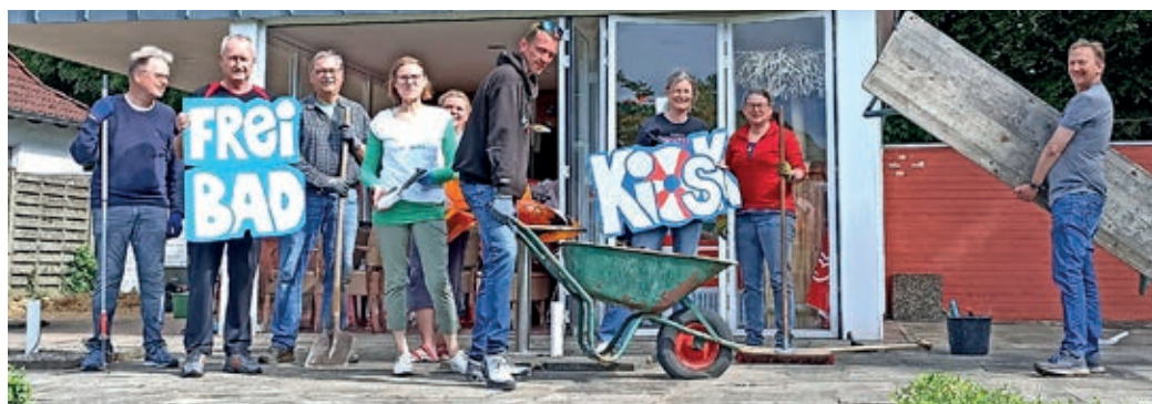
Tatkräftiges Team: Die Freibadrenovierung ist im vollen Gange.
