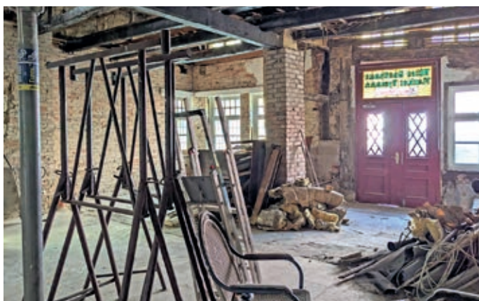
Im Inneren des historischen Hauptgebäudes erkennt man noch die ehemalige Gaststätte, aber man erahnt auch schon die zukünftigen Wohneinheiten.
