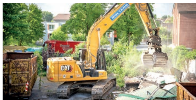
Dem Abrissbagger fielen nicht nur die Garagen zum Opfer, sondern auch die ehemalige Terrasse und das darunter liegende Schwimmbad.
