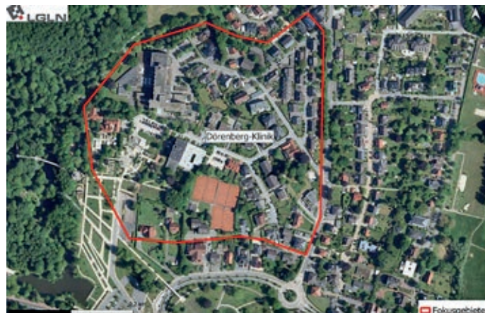
Im Gebiet Dörenberg-Klinik wäre ein Ausbau von Wärmenetzen möglich.
