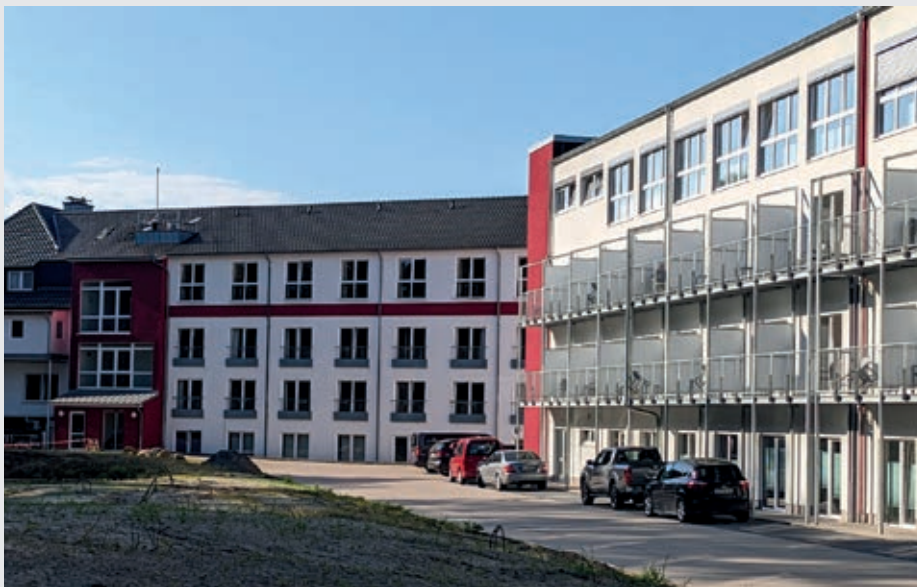
Auch das Bestandsgebäude ist modernisiert worden.
