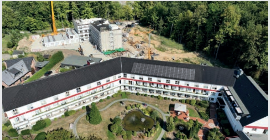
Das Bild aus der Vogelperspektive ist während der Bauphase entstanden. Es zeigt auch die landschaftlich reizvolle Umgebung.
