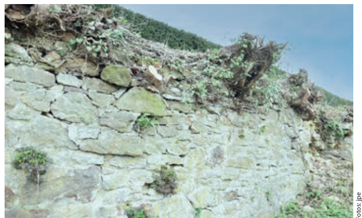
Das Bauwerk steht unter Denkmalschutz und soll jetzt durch eine Fachfirma instandgesetzt werden.
