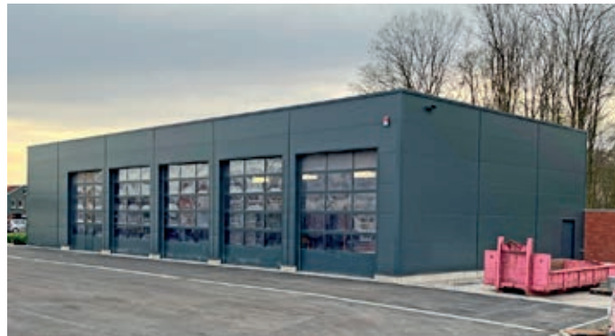
Fast fertig gestellt: das neue Feuerwehrhaus der Ortsfeuerwehr Bad Iburg an der Osnabrücker Straße.
