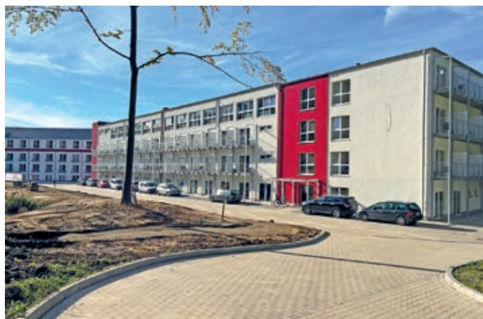
Der Anbau der Rehaklinik Sonnenhof ist seit Juni in Betrieb.
