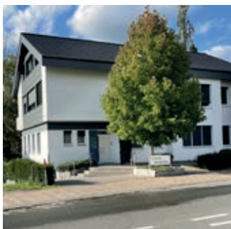
Das ehemalige Helios-MVZ wird künftig als „Praxis an der Tegelwiese“ eröffnet.
