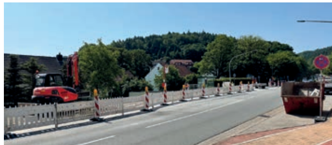
Die Ampel auf der Teutoburger-Wald Straße ist bereits abgebaut, auch die Baustelle soll bald verschwinden.
