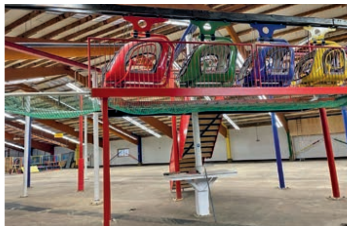
Das ehemalige Ballorig in Iburg wurde ausgeräumt und kernsaniert, die Schwebebahn blieb erhalten.
