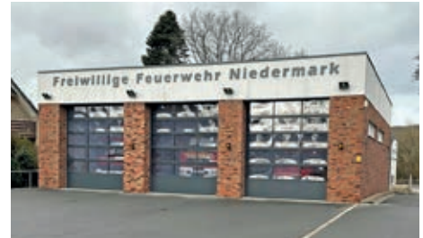
Das Feuerwehrgerätehaus in der Niedermark ist keine optimale Lösung mehr für die Anforderungen an die Feuerwehr.
