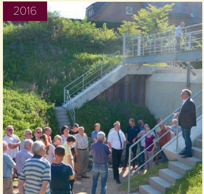
Kernstück des Bauwerks ist die fünf Meter überirdisch sichtbare und vier Meter unterirdisch befestigte Stahlbetonwand.
