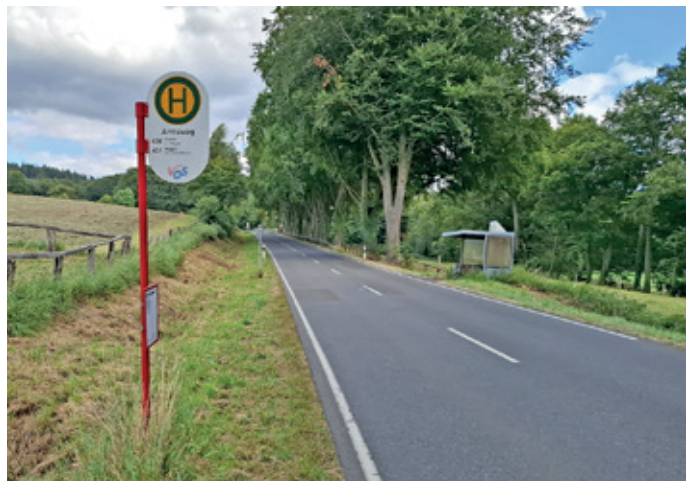
An der Iburger Straße entsteht ein Radweg. Wegen der Bauarbeiten wird sie auf einem Teilstück halbseitig gesperrt.
