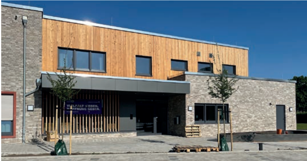
▲ Mit Klinker und Holz ist der moderne Bau der neuen Kita im Goldbachtal verkleidet.
