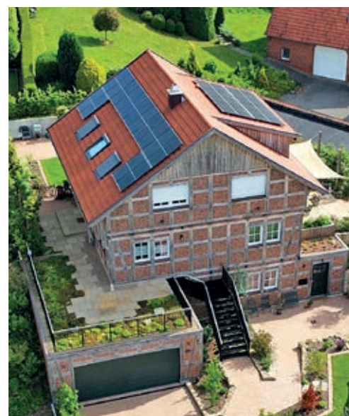
Auf diesem mit einer Drohne aufgenommenen Foto werden die PV-Anlage und der begrünte Dachgarten auf dem Fachwerkhaus sichtbar.
