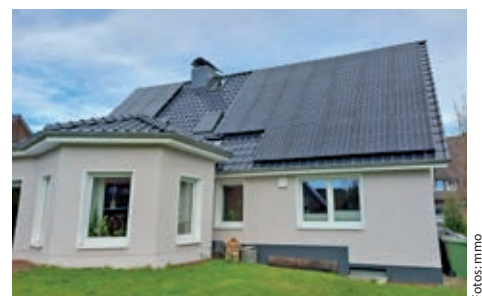
Unter anderem die Photovoltaik-Anlage auf dem Dach macht das Haus der Hülsmanns klimafreundlich.
