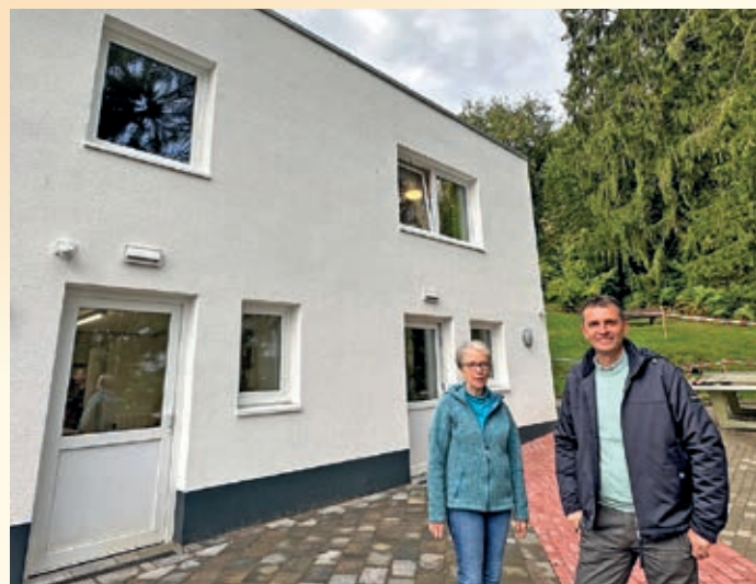
Christel Steinkamp und Gemeinderat Markus Hestermeyer freuen sich über den neuen Anbau und die gelungene Sanierung des Schullandheims.
