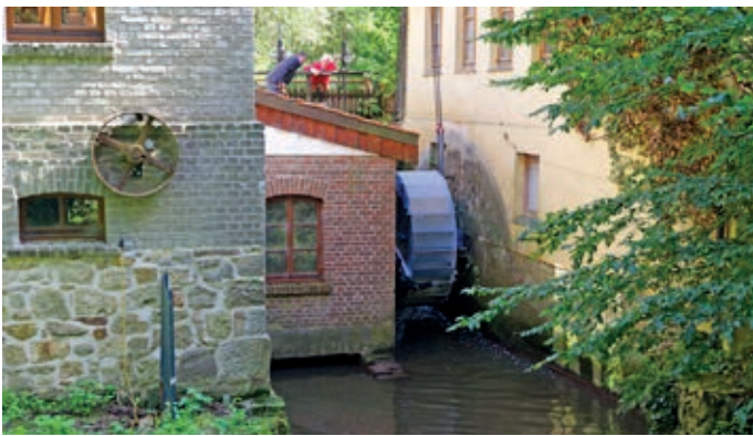
Das neue Wasserrad ist montiert.
