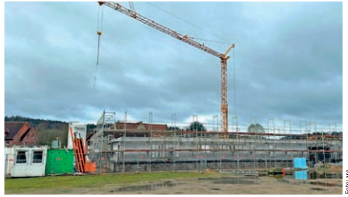
Die Mittel aus dem diesjährigen Haushalt der Gemeinde Hagen fließen unter anderem in die neue Kita, die derzeit in Gellenbeck gebaut wird.
