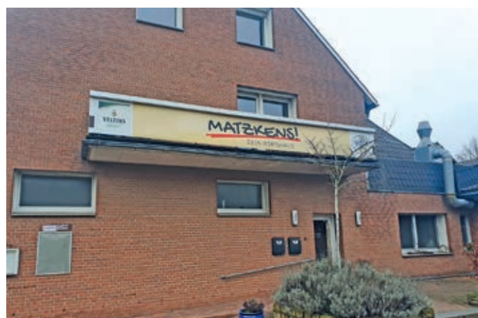
Für die Immobilie an der Natruper Straße wird ein neuer Pächter gesucht.
