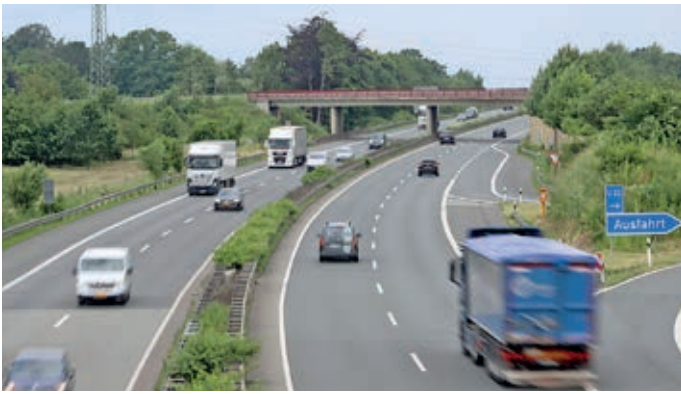
Die Überführung der Allendorfer Straße über die A30 wird ebenfalls abgerissen und neu gebaut.
