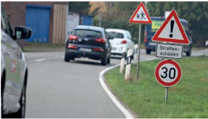
Tempo 30 wegen Straßenschäden: Bei der Buerschen Straße in Eicken-Bruche handelt es sich um eine Landesstraße (L90).
