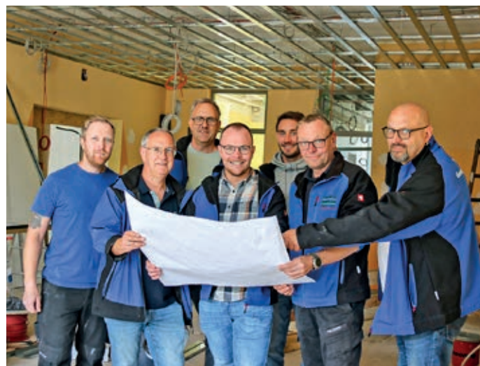
Ein Teil des ZGM-Teams um Fachbereichsleiter Anton Hornstein (rechts) während der Bauphase an der Freiherr-vom-Stein-Schule in den Sommerferien.
