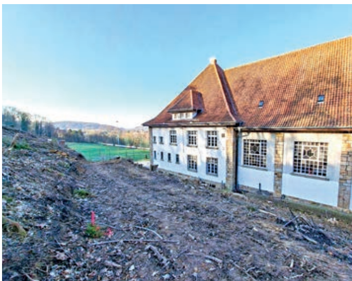
Ungewohnter Blick auf die „Alte Wanne“: Mit den Rodungsarbeiten sind bereits die ersten vorbereitenden Arbeiten für die Sanierung und Erweiterung des denkmalgeschützten Gebäudes erfolgt.
