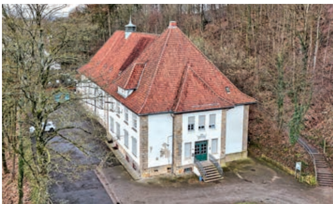
In Kürze sollen die Arbeiten zur Sanierung und Erweiterung der „Alten Wanne“ im Stadtteil Georgsmarienhütte beginnen.
