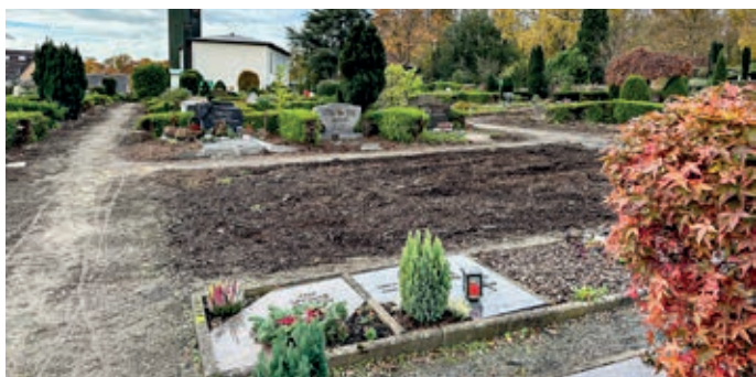
Das neue Urnengemeinschaftsgrab entsteht auf dem Friedhof Harderberg, wo derzeit die Sanierungs- und Umgestaltungsmaßnahmen laufen.
