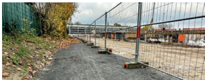
Wieder nutzbar: Der Verbindungsweg entlang des Baufeldes für den Neubau der Michaelisschule.
