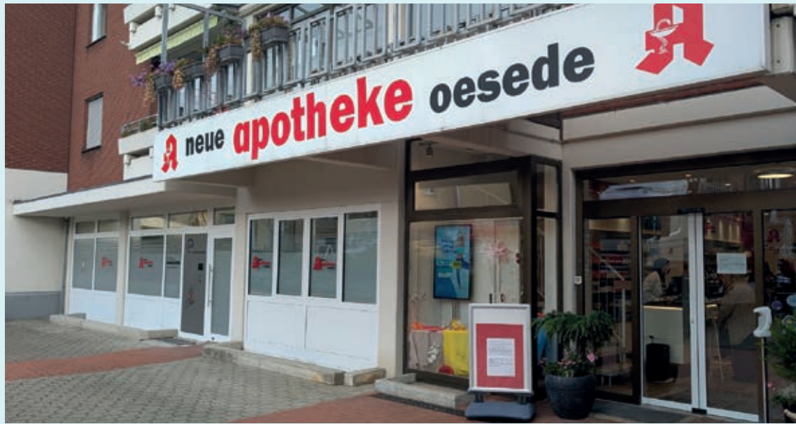
An der Fassade kann man schon von außen sehen, wie groß die Neue Apotheke Oesede durch den Umbau geworden ist.
