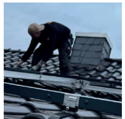
Tom Walhorn (Dachdecker und Photovoltaik-Monteur)
