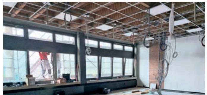
Endspurt bei der Fertigstellung der Biologieräume.
