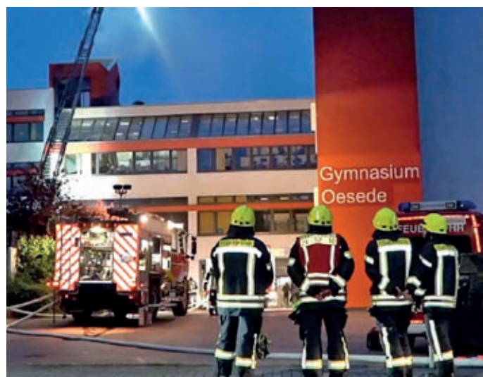
Schock in den frühen Morgenstunden: Am 11. Mai vergangenen Jahres gerieten das obere Treppenhaus und Teil des Dachs am Gymnasium Oesede in Brand.
