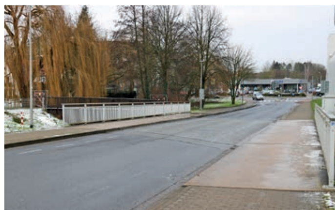
In unmittelbarer Nähe zum „Kirmessteg“ führt seit Anfang der 2010er-Jahre die Brücke der „Georg-Elser-Straße“ über die Düte. Diese wurde beidseitig mit Gehwegen ausgeführt.
