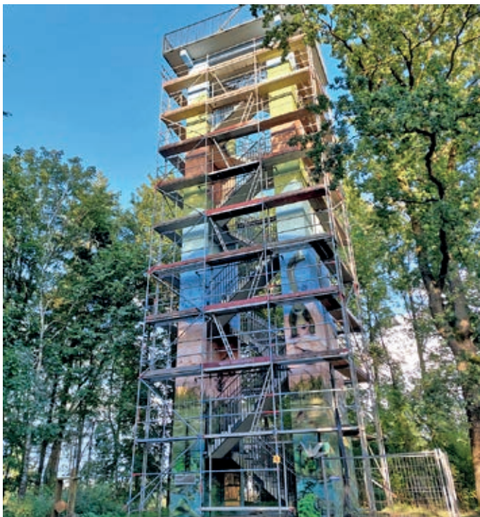
Der eingerüstete Turm. Die Bemalung ist schon gut zu erkennen
