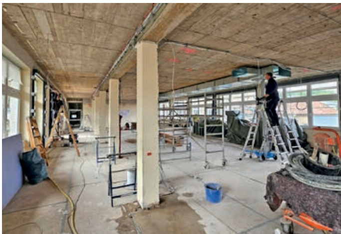
Die Sophie-Scholl-Schule am Standort Kirchstraße in Alt-Georgsmarienhütte bildet einen der Schwerpunkte der derzeit laufenden Sanierungs- und Modernisierungsarbeiten. Unter anderem wird die Aula der Schule neu hergerichtet.
