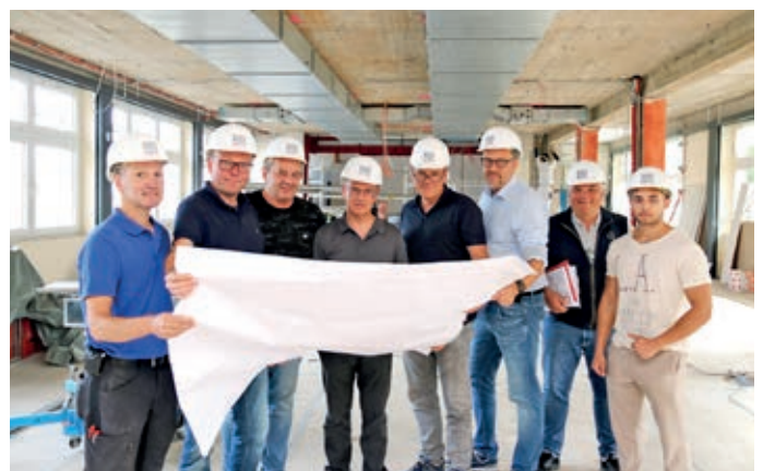
Das Team des ZGM bei der Begutachtung der Baustelle in der Sophie-Scholl-Schule. Nur eine von vielen Baustellen, die in den Sommerferien gleichzeitig durch die Mitarbeiter betreut werden.
