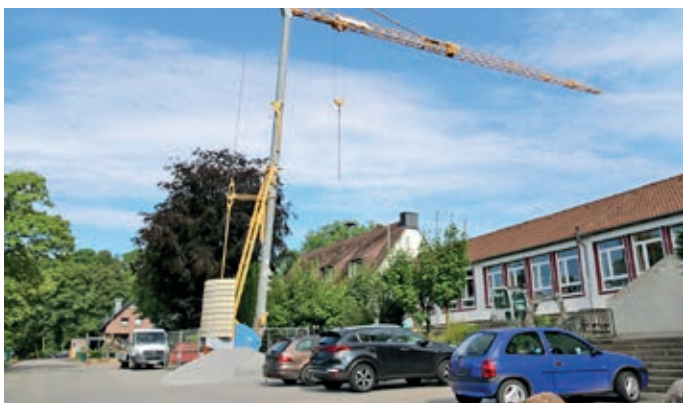
Auch an der Grundschule am Harderberg sind die Handwerker unterwegs. Dort werden am Gebäude vorbereitende Arbeiten zur späteren Umgestaltung des Schulhofes vorgenommen.
