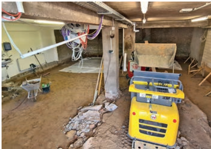
Für die erforderlichen Abdichtungsarbeiten an der Harderberger Schule muss auch eine neue Bodenplatte im Keller eingezogen werden.
