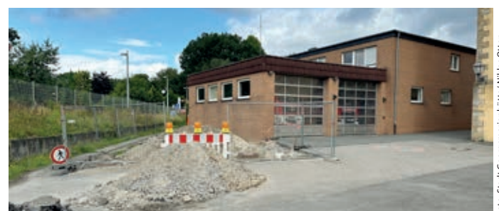
Die Arbeiten für die Errichtung der Kalthalle haben begonnen.
