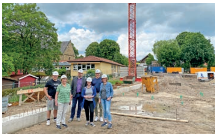
Die SPD-Fraktion informierte sich über den Baufortschritt am Krippenhaus in Kloster Oesede.
