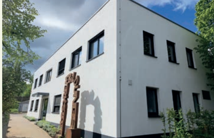
Der inzwischen fertiggestellte Anbau mit Mensa
