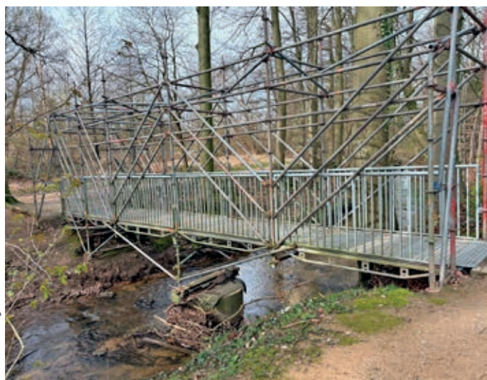
Seit Ende 2021 führt eine Behelfsbrücke am Friedhof Kloster Oesede über die Düte.
