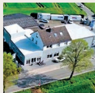
Seit 111 Jahre am selben Standort: H&L Meer an der Wellendorfer Straße 83 in Georgsmarienhütte.
