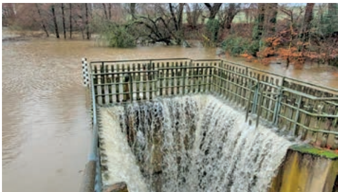
Die Regenrückhaltebecken waren gut gefüllt – teilweise sogar zu gut, wie auf dem Bild in Kloster Oesede zu erkennen ist.
