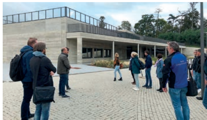
Außenansicht auf den Veranstaltungsraum im Sportheim des Sport- und Freizeitareals Rehlberg, das nun zur Nutzung freigegeben wurde.
