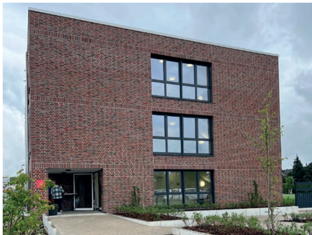
Das neue Firmengebäude der edikoo am Bahnhof 4 ist nach gut einem Jahr Bauzeit fertiggestellt worden.
