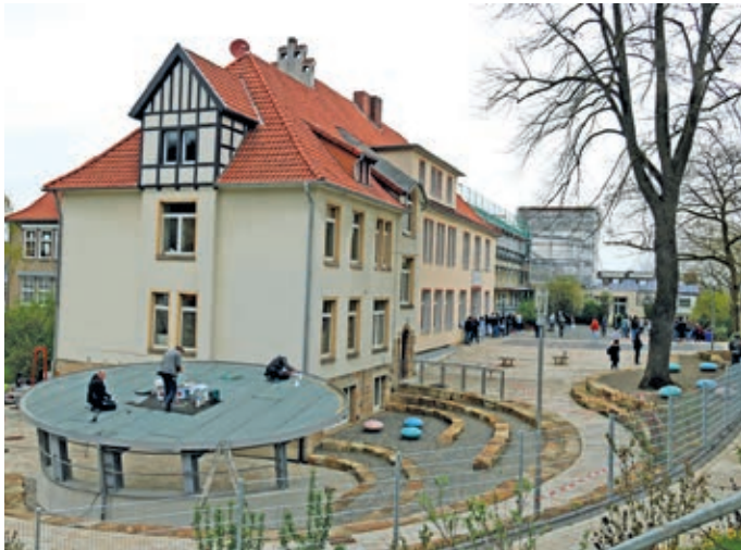
Letzte Arbeiten am neuen Abschnitt des Schulhofes der Sophie-Scholl-Hauptschule im Standort Alt-Georgsmarienhütte.
